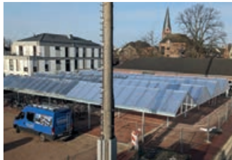
Ausbau der Abstellanlage Bahnhof-Südseite
